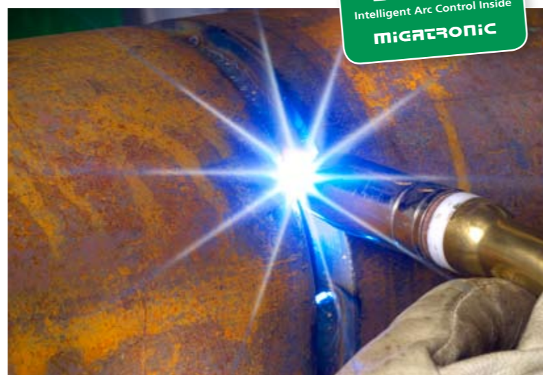
IAC™ – Spawanie warstw graniowych pionowo w dół rury ciepłowniczej. Prędkość spawania zostaje znacznie zwiększona w porównaniu z tradycyjnym spawaniem w górę.
