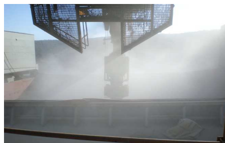
Przed montażem systemu
